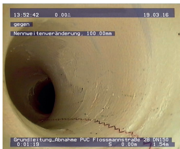
Nach erfolgreicher Sanierung
